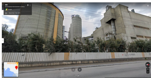
Cementárna HALYPS, pohled z ulice. Zdroj: Google Maps.
