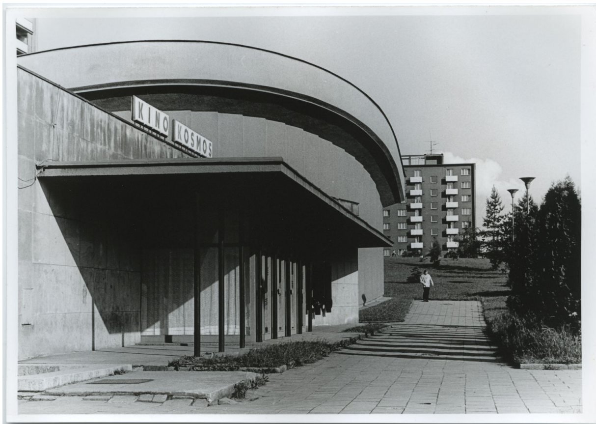
Třinec – Terasa. Pohled na kino Kosmos a dům č. p. 795, 1974; autor: Viktor Klimša; Státní okresní archiv ve Frýdku-Místku
