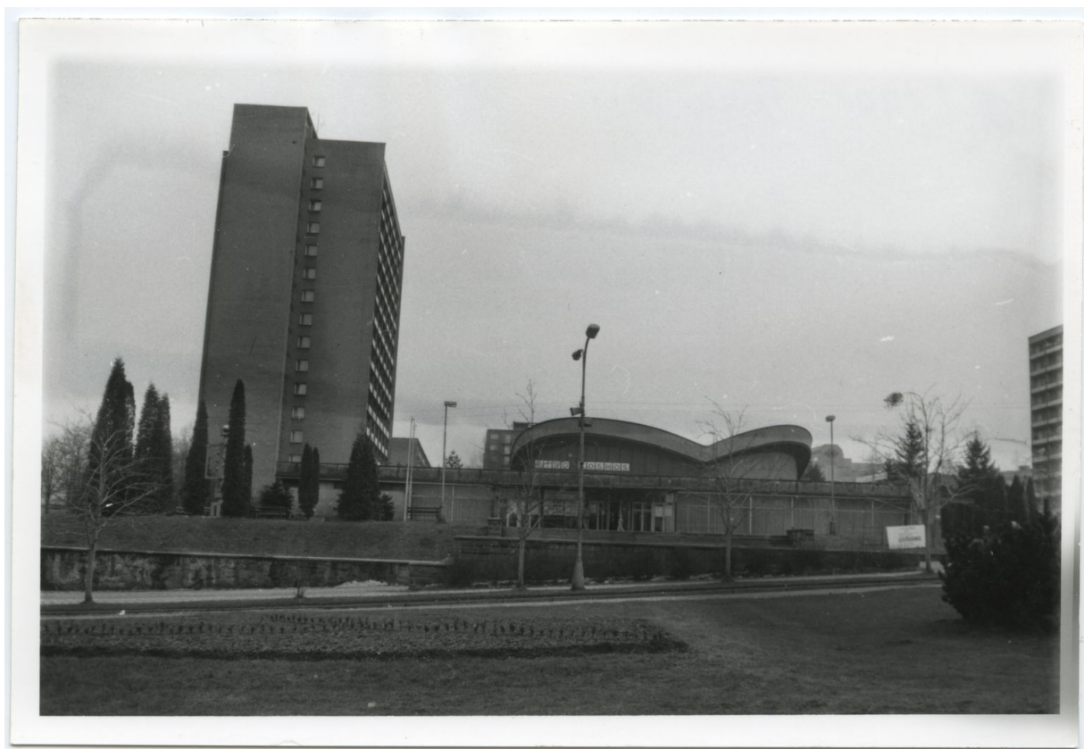
Třinec – Terasa. Pohled na kino Kosmos a dům č. 795, 1974; Státní okresní archiv ve Frýdku-Místku
